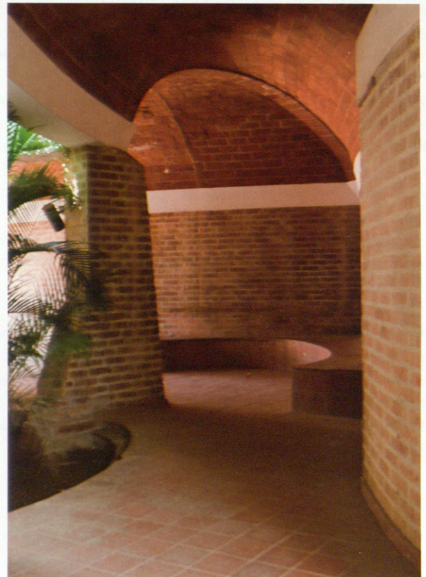
Cúpulas de los pabellones de la Escuela de Artes Plásticas, Ricardo Porro. Domes of the pavilions at the School of Visual Arts, Ricardo Porro.
